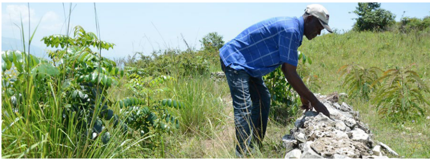
«Euer Einsatz hat diese Ordnung bewahrt» – In Haiti verhindern Steinmüerchen die Erosion.
