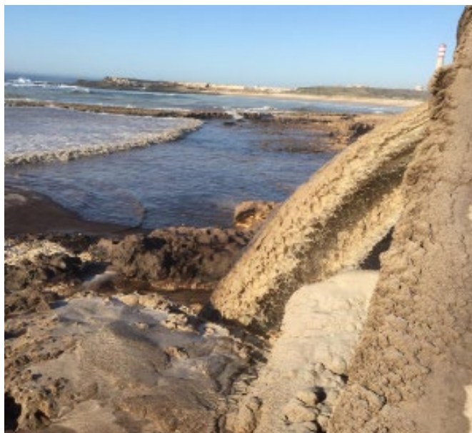
Abwässer der OCP-Fabrik Safi werden direkt ins Meer geleitet. ©SWISSAID
